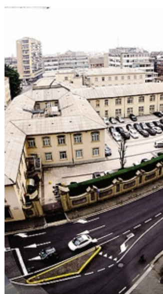
Sede Italcementi di via Camozzi
